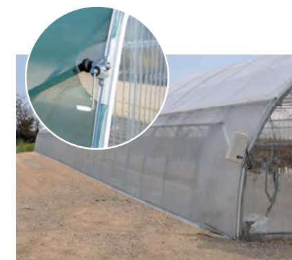
Ventilación lateral continua por enrollamiento
